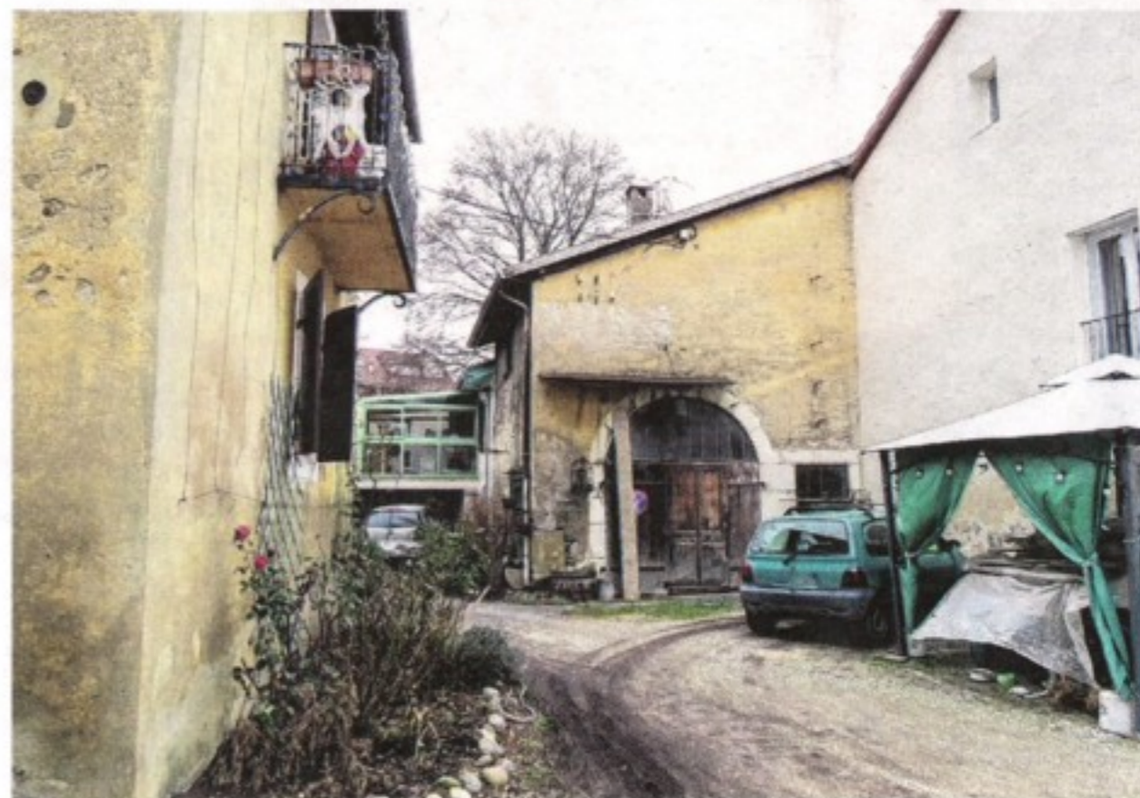
En février 2019, le bâtiment de la forge n'a guère changé d'aspect, et la ruelle qui passe devant la cour porte le nom de passage de la ferronnerie.
