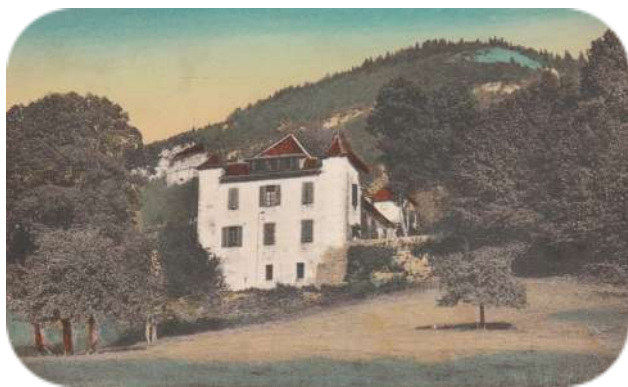
Pomier, un site antique de surveillance, puis un établissement religieux ? Collection Dominique Bouverat.
