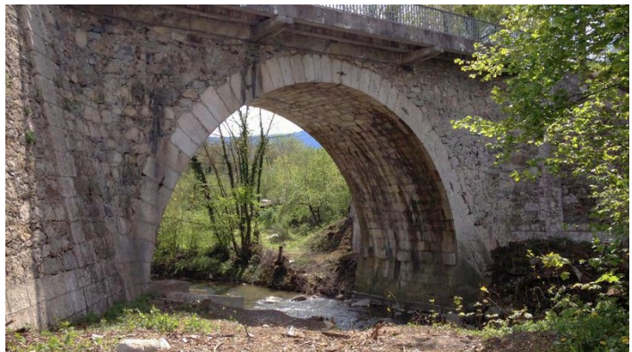
Le pont Manera.
