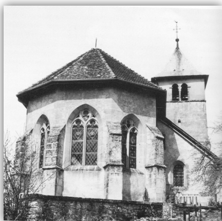
L'église Saint-Martin de Cernex figure elle aussi dans le recensement de ces chefs d'œuvre. Ici le chevet du chœur et sa couronne de contreforts « genevois ».
