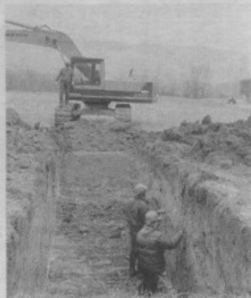
Les fouilles près des futures têtes de tunnel de l'autoroute.
