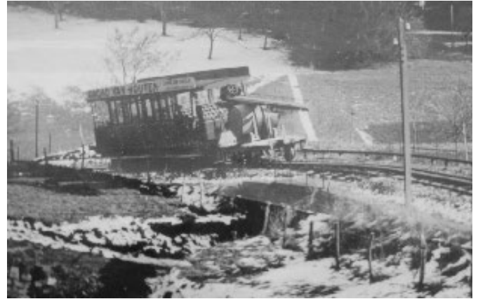
Fig. 18 - En amont de la halte de Haut-Mornex une automotrice (2 e époque) et un wagonnet chargé d'une citerne d'eau et d'un bob près du pont n° 15 ; à droite un poteau de la ligne téléphonique de la Compagnie.
