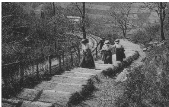
Fig. 37 - Escalier du Pas de l'Échelle réalisé lors de l'établissement de la ligne Veyrier – Monnetier en 1893 parallèlement à la voie ferrée en tranchée ; cet escalier de 100 marches remplaça le sentier serpentant dans le vallon.
